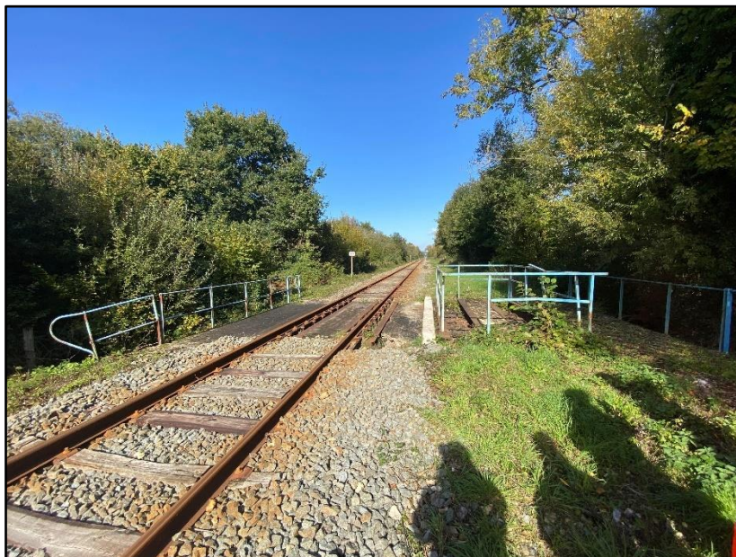
Figure 2 : Ligne 325 000 - Vue de l'ouvrage au Pk 139+986
