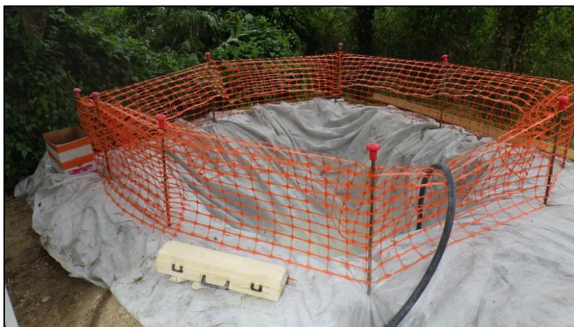
Figure 14 : Ligne 325 000 - Exemple d'un bassin de décantation provisoire pour les eaux d'exhaure de batardeaux
