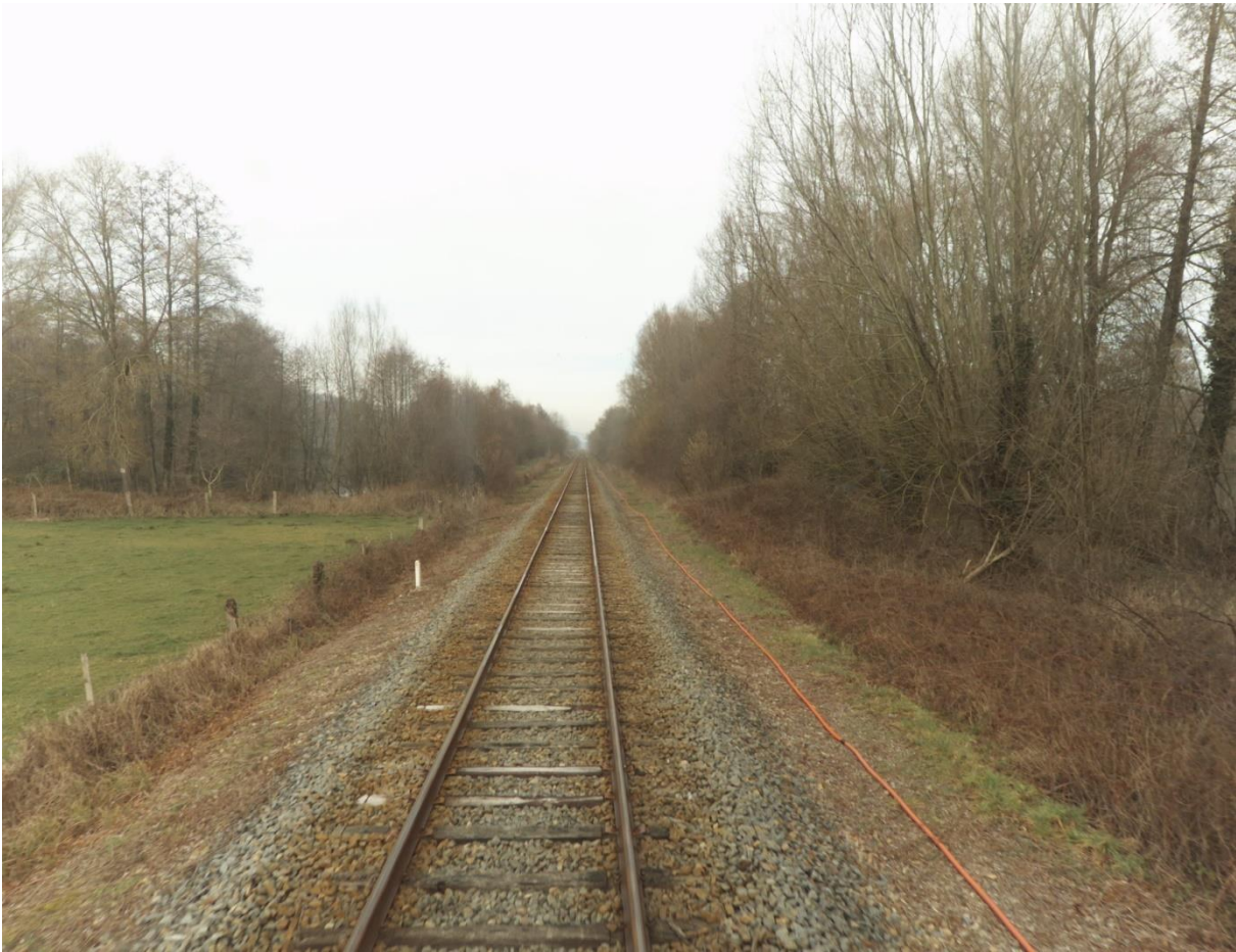
Figure 10 : Ligne 325 000 – Accès sur le côté droit le long de la voie ferrée entre le PN 126 et le Pont-Rail au Pk 139+986
