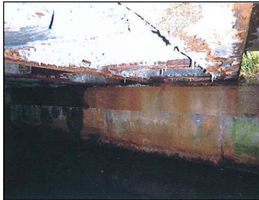
Figure 6 : Ligne 325 000 - Intrados du tablier en service existant
