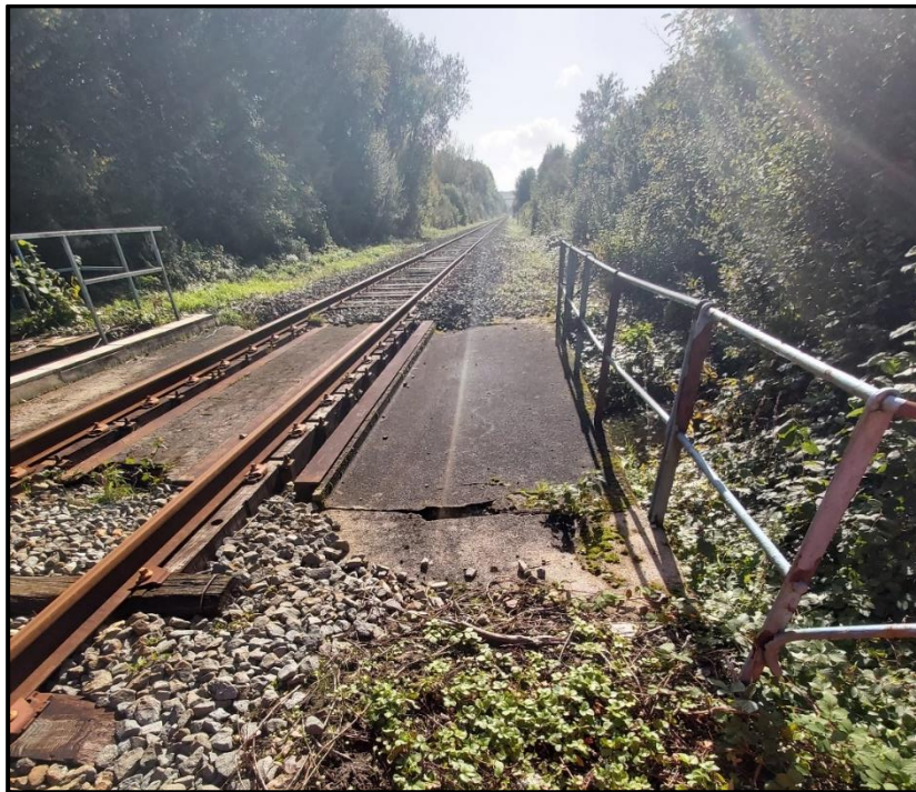
Figure 5 : Ligne 325 000 – Photographie de l'ouvrage au Pk 139+986
